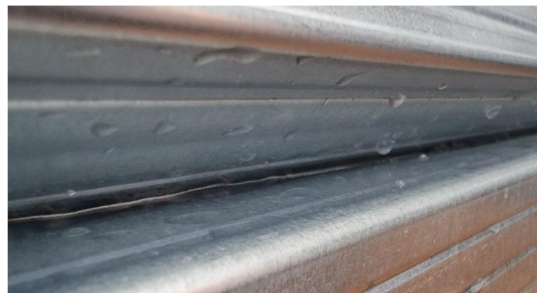
Obr. 2: Vlhkost mezi profily. Uvnitř se může objevit bílá rez ve velmi krátkém čase.
