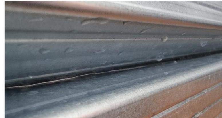
Abb. 2: Nässe zwischen den Profilen. Weißrost kann sich innerhalb kürzester Zeit bilden.
